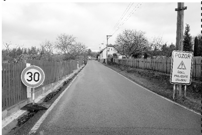
❖ Ke konci ledna zahájila společnost EG. D prostřednictvím firmy První tábořské elektromontáže rekonstrukci nízkého napětí v Červeném Záhoří. Práce budou probíhat v ulici Hlinická, Průběžná, Ve Dvoře, Dolní a Prostřední. Do poloviny roku 2025 bude nadzemní vedení nízkého napětí nahrazeno vedením podzemním.
